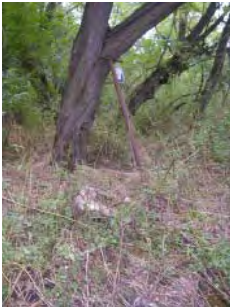
Strommast im Katzelsdorfer Wald
